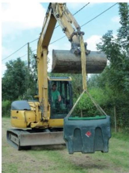
Foto: ophangpunt voor het hijsen met de graafmachine - © Inverde
